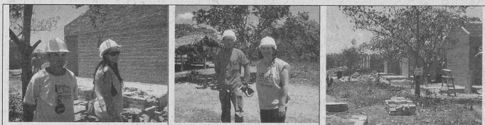
(Visita dos Técnicos da Sasc nas construções das casas )
