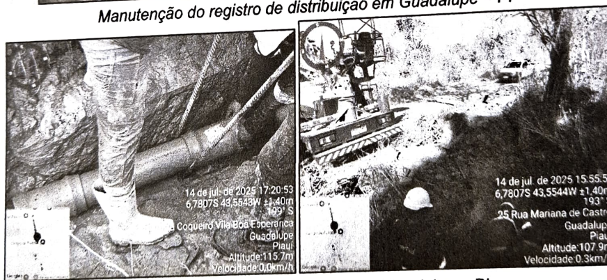
Manutenção em rede de 150mm em Guadalupe -PI
