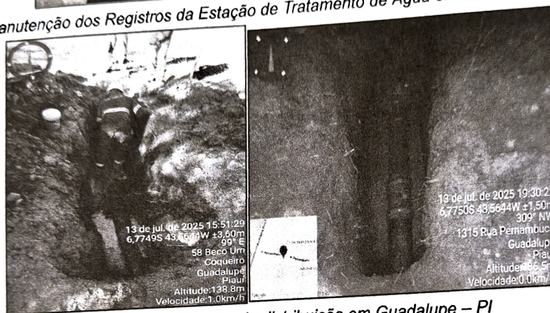
Manutenção do registro de distribuição em Guadalupe - PI
